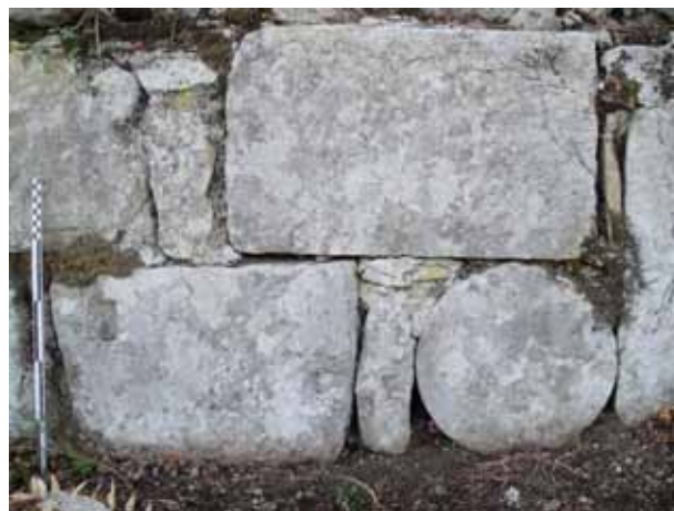
Fig. 18 - Opera muraria con materiale di spoglio, nartece della basilica A Sl. 18 - Zidarski radovi i ponovo upotrijebljeni materijal, narteks bazilike A
