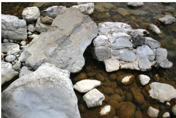
Sl. 23. Djelovi mosta u koritu rijeke Cijevne kod sela Stanaj
