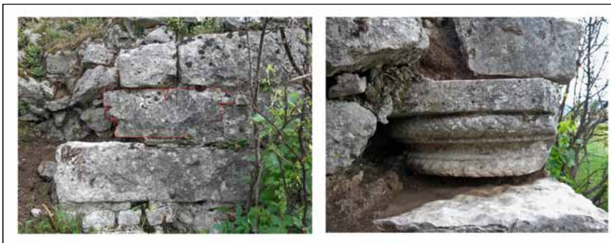
Sl. 4 - Baza stuba uzidana u spoljašnje lice sjevernog bedema
